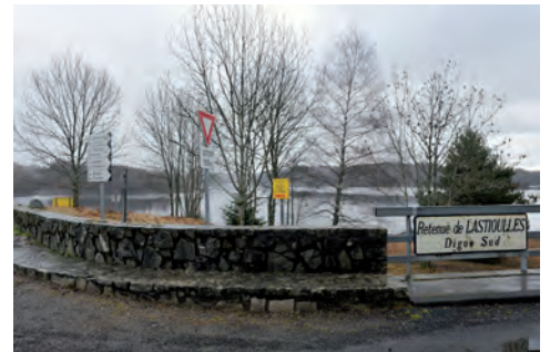
Signalétique sur l'édifice du barrage
