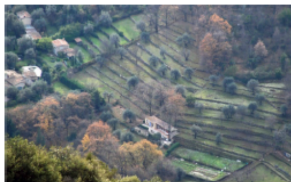
Terrasses vers le Bar-sur-Loup, vue depuis Gourdon Source : PP CASA / Action Préservation et gestion des restanques
