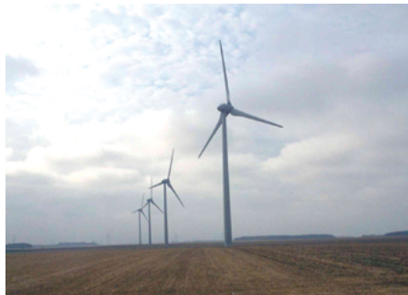
Eoliennes dans le sud de l'Essonne DRIEE 2012
