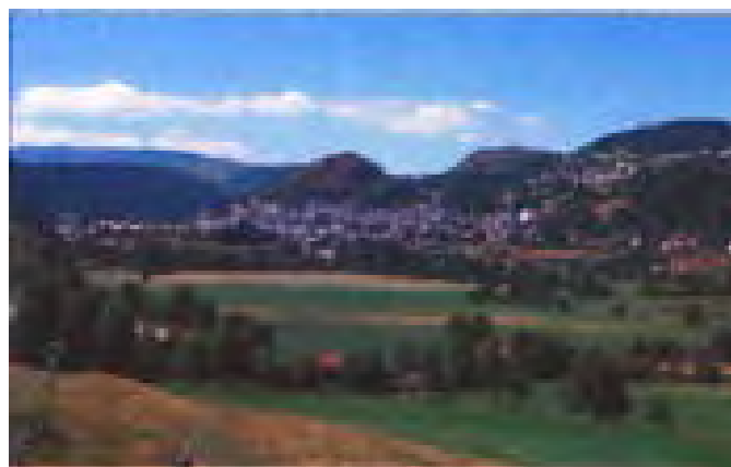
Murat - Extensions pavillonnaires en périphérie de la ville ancienne.
