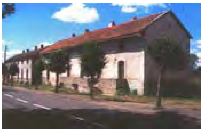
Habitat ouvrier à Champagnac - Témoignages de l'ancienne activité minière.
