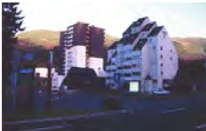
Station du Lioran - Une architecture de type urbain dans un contexte naturel.
