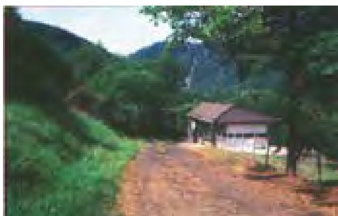
Habitation légère de loisir implantée à demeure - Aménagements extérieurs.
