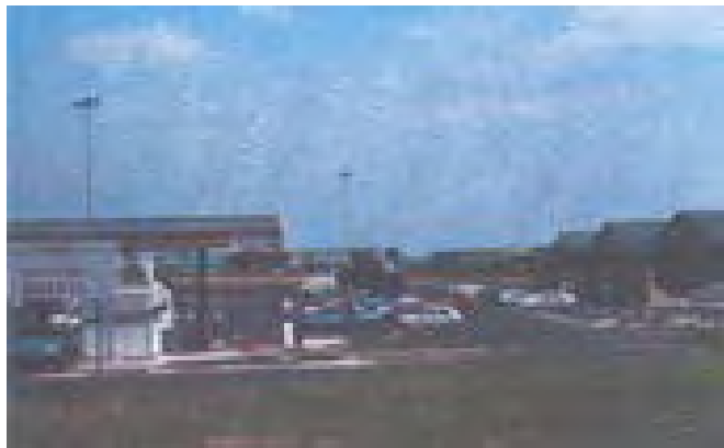
Entrée par la D926 (entrée Ouest) - Traversée de la zone commerciale de Montplaisant - Hétérogénéité du bâti.
