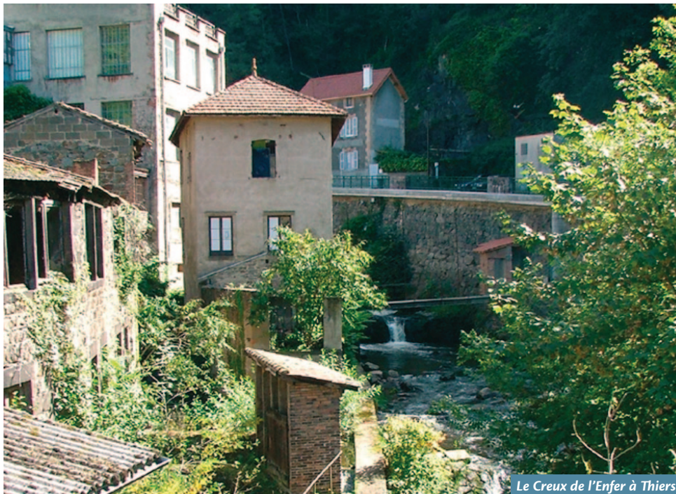
Anciens bâtiments industriels le long de la Durolle
