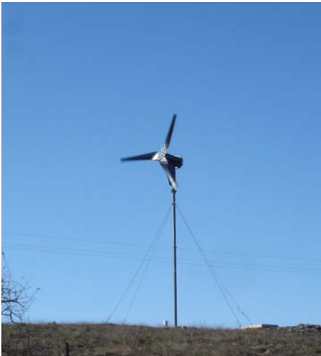
Eolienne haubanée (hauteur : 15 mètres)
