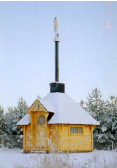
Eolienne à axe vertical sur une cabane d'estive dans la vallée d'Aspe (66)
