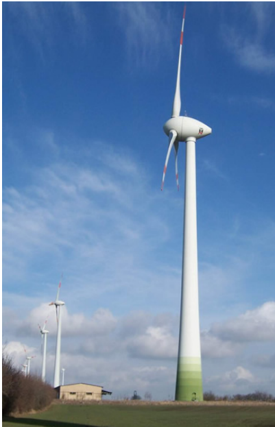
Dégradé de vert sur le mât d'éoliennes implantées en Allemagne
