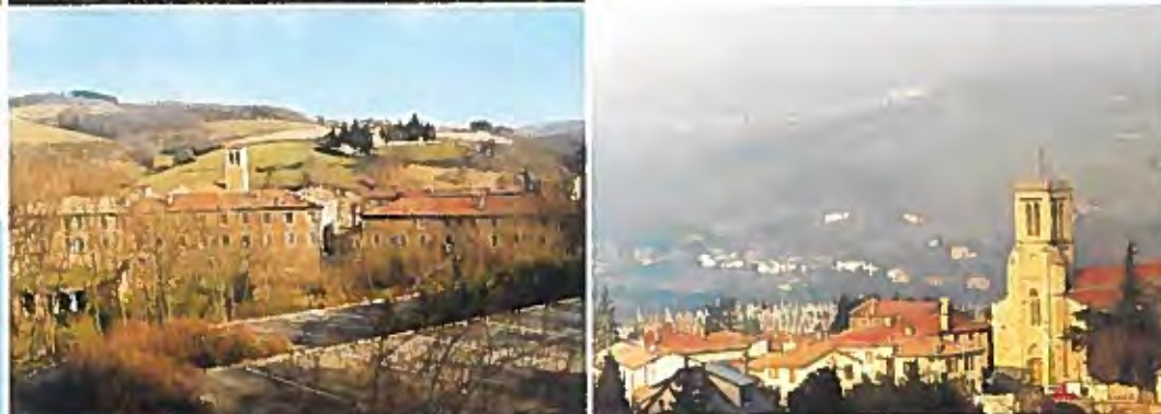
La Chartreuse de Sainte-Croix-en-Jarez et un village des Monts du Lyonnais : l'architecture témoigne des croyances
