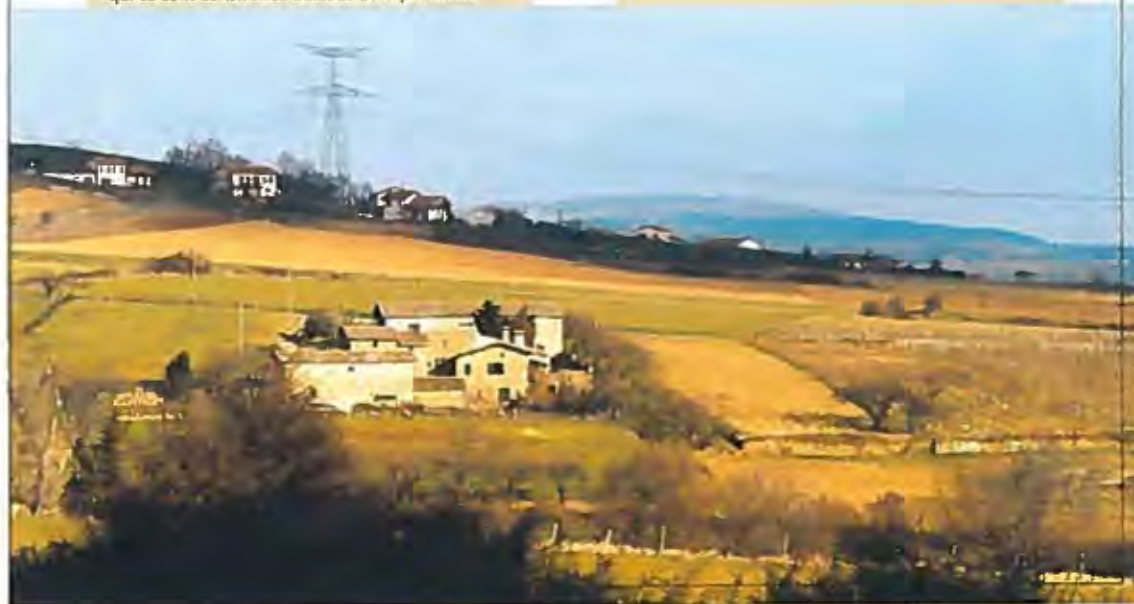
Ligne électrique THT dans le Pélussinois. Sa présence n'a pas gêné les résidences qui se sont construites dessous ou à proximité
