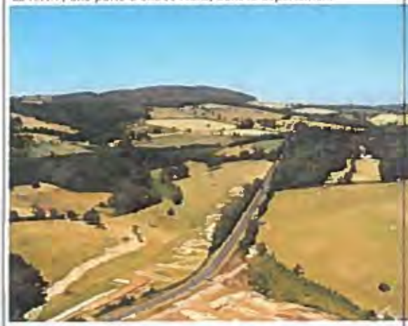
La R.N.7, une porte d'entrée Nord, dans le département
