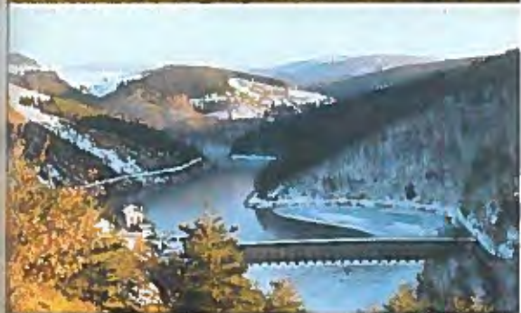
Barrage de Cotatay
