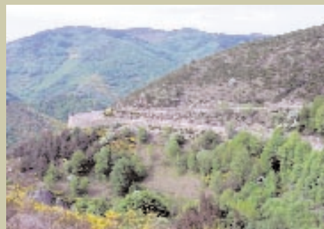
ROUTE D'ACCÈS AU COL DE MÉZILHAC EN LACET
