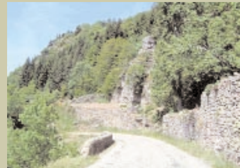
TERRASSES ET PARAPETS LE LONG DE LA D241
