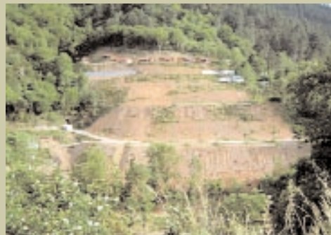
VALLÉE DE L'EYRIEUX: TERRASSEMENTS POUR HABITAT DE VACANCES
