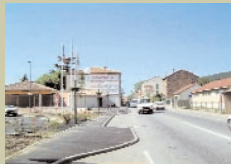
AMÉNAGEMENTS LE LONG DE LA RN 86 (CHARMES-SUR-RHÔNE)
