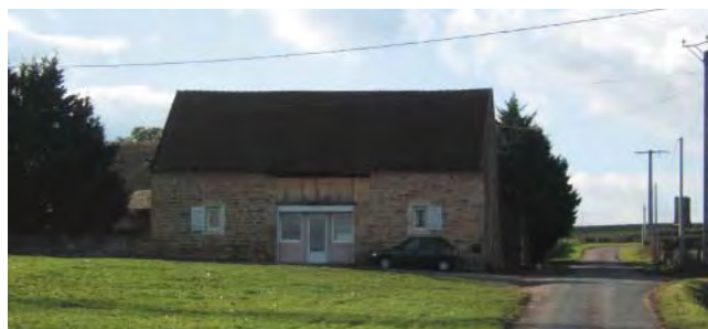
Vallon en Sully, Davoué. L'intention était bonne, mais le coffret blanc du volet roulant descend visuellement le niveau du linteau. Il n'est plus aligné avec les linteaux de fenêtres. De plus la teinte blanche le rend très visible. D'autant que le bois posé en partie supérieure se confond de loin avec la teinte de la pierre. On ne perçoit plus l'ouverture initiale de la porte de grange, l'équilibre des masses est perdu.
