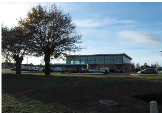
Vaux : Une salle de sports récente aux Trillers. Une belle réalisation en soi, un manque évident de réflexion en matière d'urbanisme et d'insertion paysagère dans ce village.
