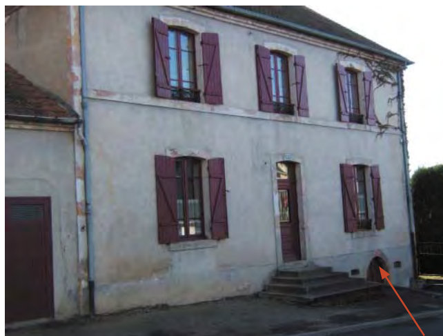
Estivareilles : Rez de chaussée surélevé de 5 hauteurs de marches (1.00m environ), entrée de la cave sous le niveau de la route.
