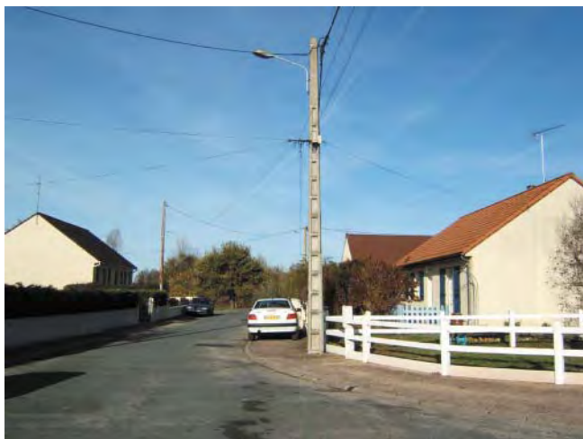
Estivareilles : Présence forte des réseaux dans un lotissement.
