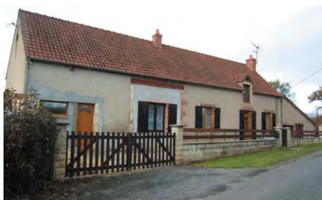
Nassigny Champvallier : Créer une ouverture au centre de l'ancienne porte de grange répondait à une nécessité à l'intérieur mais n'est pas défendable à l'extérieur. Dans ce cas, il aurait été préférable de marquer l'emprise de la porte par un matériau différent, un bardage bois vertical par exemple. La fenêtre de gauche aurait été préférable à la verticale pour conserver une logique en façade.
