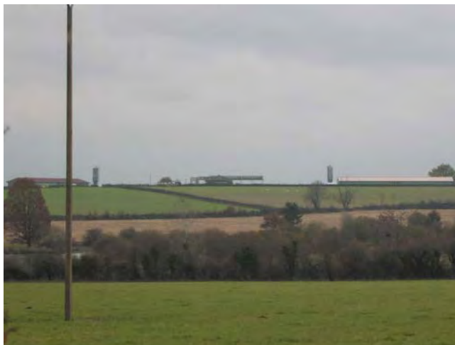
Bâtiments agricoles d'élevage hors-sol sur la commune d'Audes. Ils sont particulièrement visibles en vues lointaines du fait de leurs grands volumes et de la présence de silos de plusieurs mètres de haut. Leur position en ligne de crête renforce leur impact visuel.
