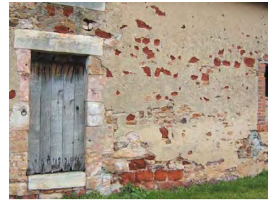
Un mur enduit dont on perçoit l'hétérogénéité des matériaux sous l'enduit. A noter la petite taille des moellons en pied de mur. Les jambages de la porte sont réalisés en grès rose taillé, ceux de la fenêtre sont en briques.
