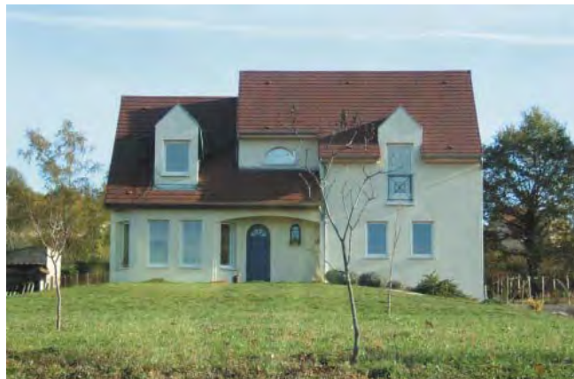
Estivareilles : une vue plus contemporaine du sujet. Si tout n'est pas satisfaisant, on retrouve une adaptation de la lucarne, un volume et une réécriture des ouvertures intéressante (en dehors des formes arrondies)
