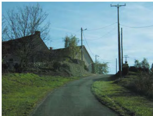
Reugny entrée de Varigny marquée par une succession de poteaux.
