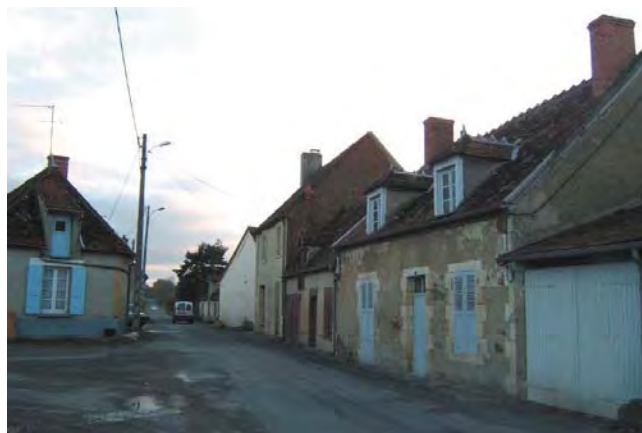
Audes : chaque petite maison de bourg possède 1 ou 2 cheminées en pignons. A noter les lucarnes à capucine, avec faîtages réalisés en « pigeons ».
