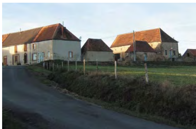
Givralais : la qualité du bâti traditionnel fait tout le charme de cette entrée de bourg. De l'autre côté, l'église répond à cette image de grande qualité.
