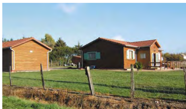
Vallon en Sully le Cluzeau : en limite d'un village au bâti traditionnel intéressant. Le bois peut être utilisé sur ce territoire dans le respect de l'architecture locale : pente de toit, ouvertures, volumétries, teintes. Un modèle qui banalise l'utilisation du bois dans la construction et apparaît en totale rupture avec le village.
