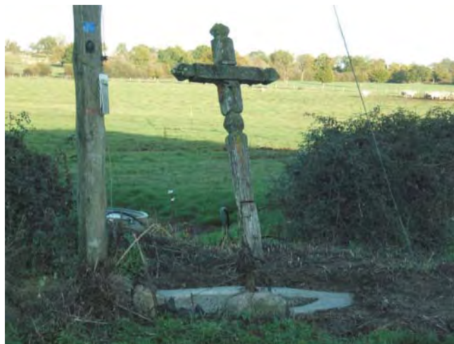
Givralais Breaucerf : une croix en bois en très mauvais état.
