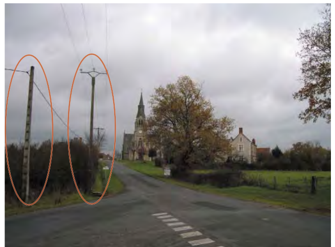
RD70 à l'entrée Sud d'Audes : les réseaux aériens du bord de route perturbent la lecture de la silhouette du bourg.
