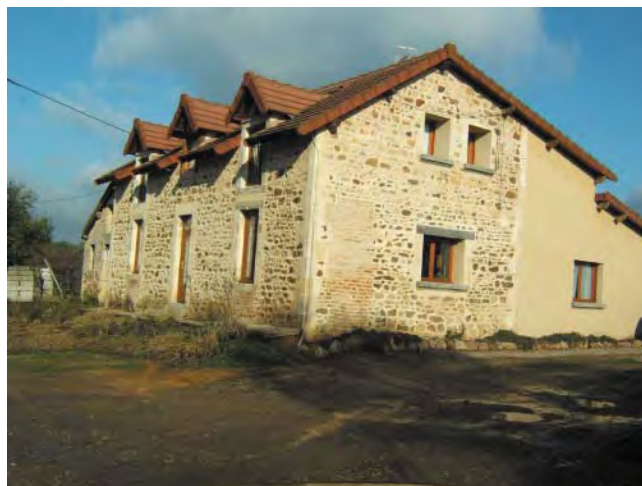
Vallon Dointe : Une maison totalement remaniée dont les combles ont été aménagés. Le rythme des lucarnes est un peu lourd. Il semble que la pente du versant arrière ait été modifiée pour augmenter le volume habitable de l'étage. Les ouvertures ne sont pas créées dans l'axe du faîtage, le pignon est totalement déséquilibré. La maison a été décrépée et rejointoyée dans la tendance du moment, ce qui ne lui est pas forcément favorable.
