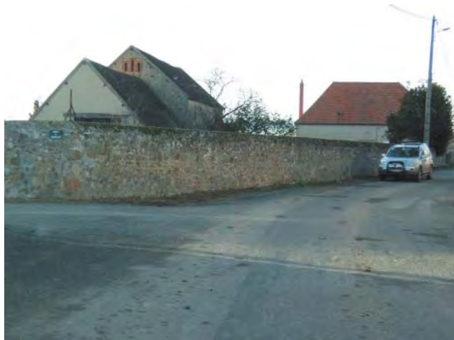
Givarlais : on ne perçoit rien de l'arrière du mur.
