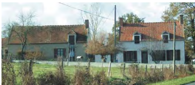
Vallon les Loges : une lucarne porte à capucine à gauche, 2 lucarnes en bâtière sur la maison à droite.
