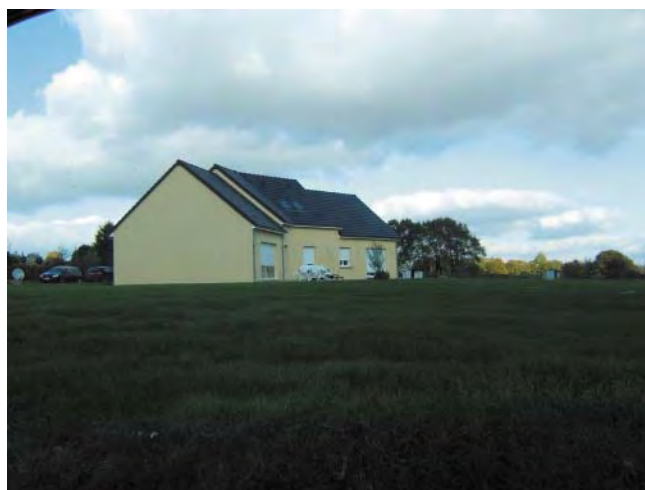
Nassigny, à l'entrée de Champvallier. Une maison qui est en totale rupture avec l'organisation du bâti dans le village. En contradiction aussi au niveau des matériaux : les toitures noires sont à éviter sur le territoire.
