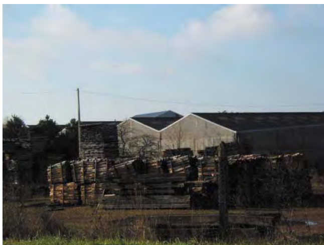
Vallon en Sully RN 144, sortie Nord. Stockage bois, volumes bâtis importants, matériaux clairs et brillants.
