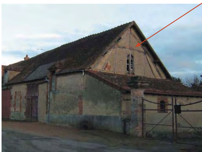
Audes : à noter en pignon : le remplissage de maçonnerie dans la première ferme. On perçoit les arbalétriers, poinçon, entrain et jambes de force.
