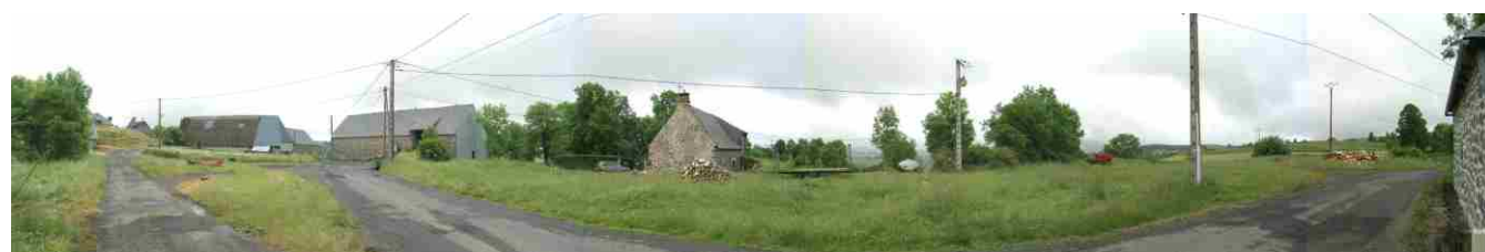
Intervention minimale sur un couderc, la qualité du lieu retrouve une évidence. Enfouissement du réseau électrique, rangement du matériel agricole.
