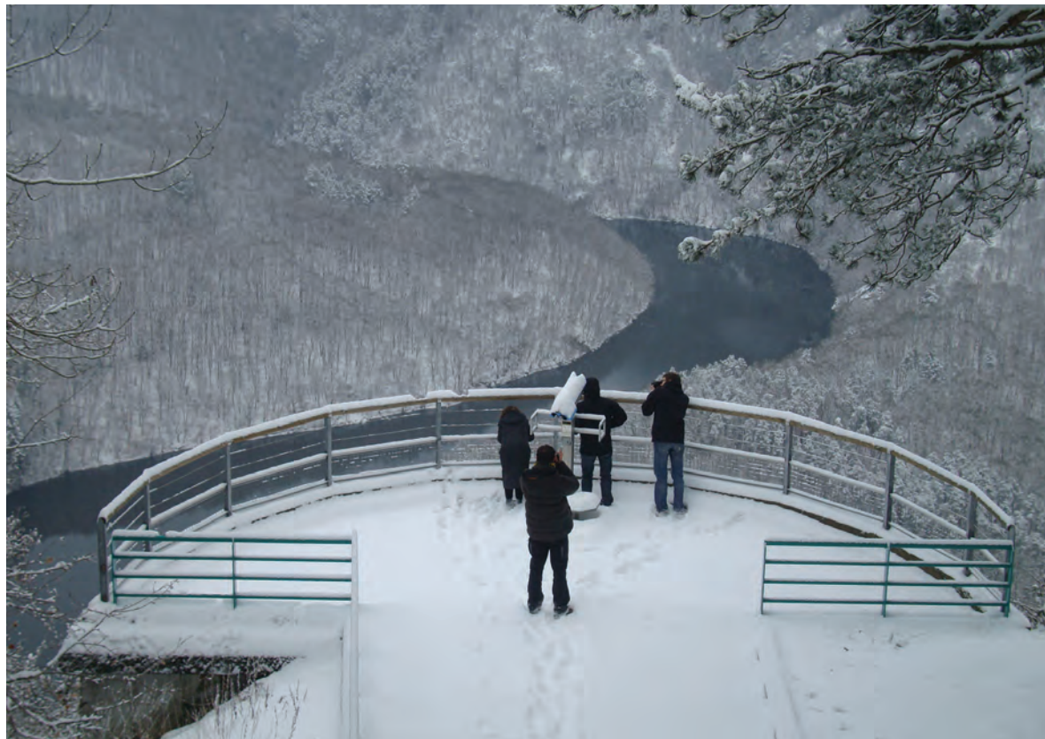
La construction du belvédère surplombant le méandre de la Sioule à Queuille met en scène l'approche par un escalier qui descend vers la vallée. C'est une rare forme très construite de belvédère.
