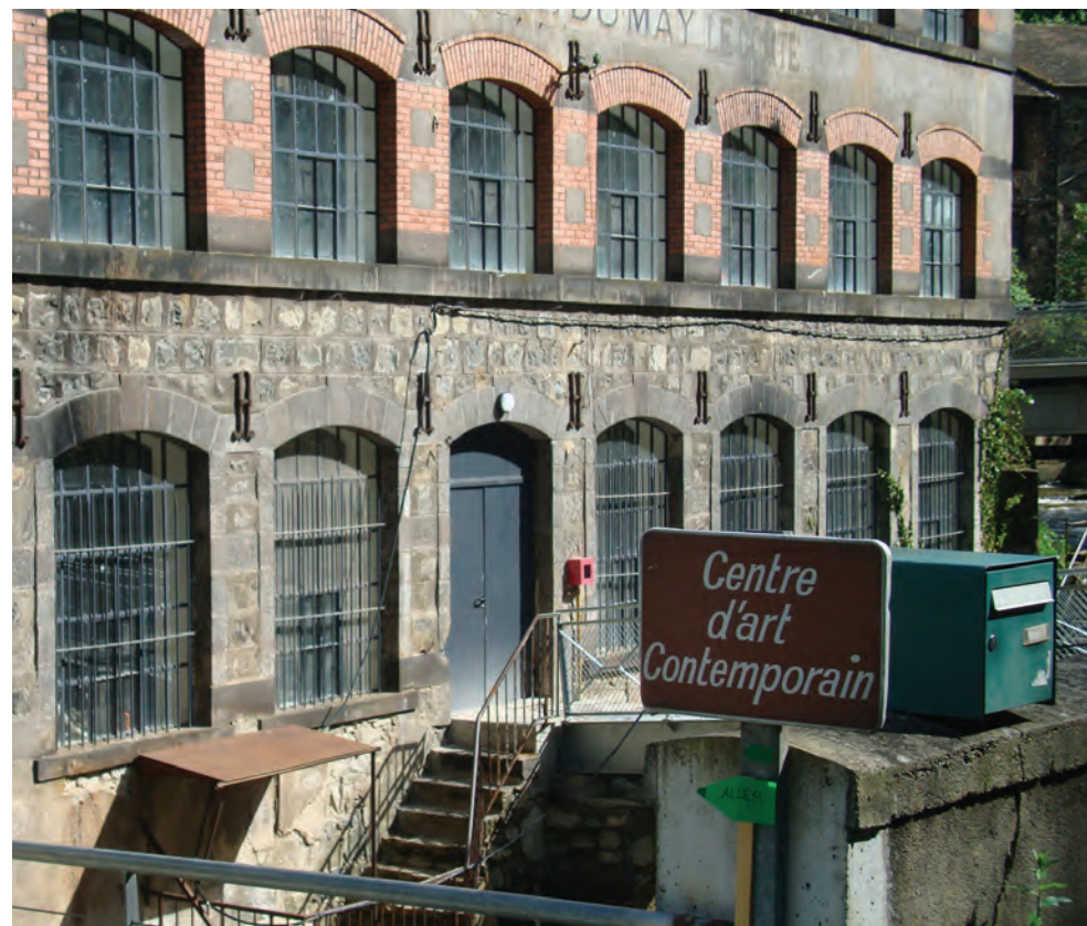
La zone industrielle historique de la vallée de la Durolle à Thiers, dans le Puy-de-Dôme, fait l'objet de multiples réhabilitations et reconversions ponctuelles de bâtiments.
