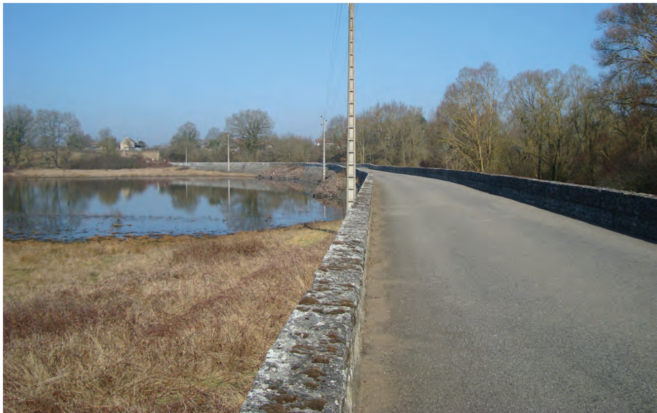
L'étang de Goule, au nord de l'Allier, fait partie du complexe hydraulique du canal du Berry construit durant le 19 ème siècle.
