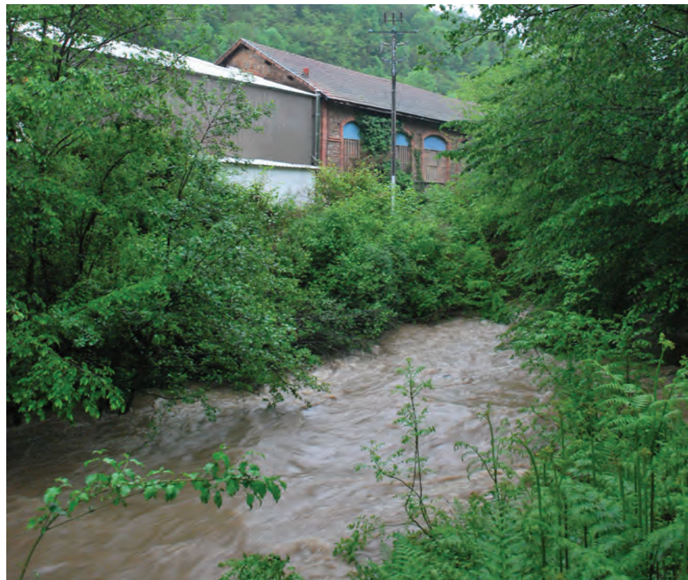
Le hameau de Salet, près de Courpière, est le témoin oublié des heures de gloire de l'exploitation des eaux thermales.
