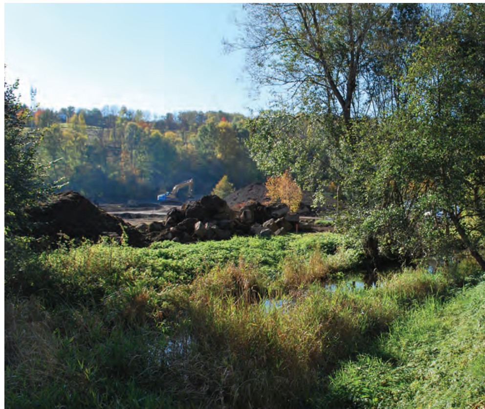
En amont du lac d'Aydat dans le Puy-de-Dôme, un chantier réhabilite une zone humide effacée dans les années 1980 par la construction de terrains de sports. La zone permettra de filtrer les eaux de la Veyre avant qu'elle ne se jette dans le lac.
