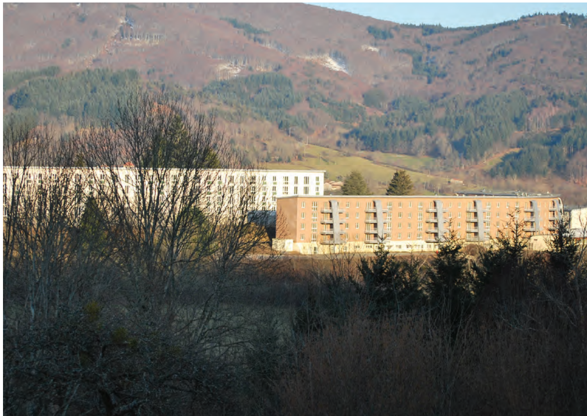
La singulière présence de ces deux « barres » d'habitations HLM à Laprugne dans la montagne bourbonnaise, construites pour loger une partie des ouvriers, est un témoin très visible de l'exploitation passée des mines d'uranium.
